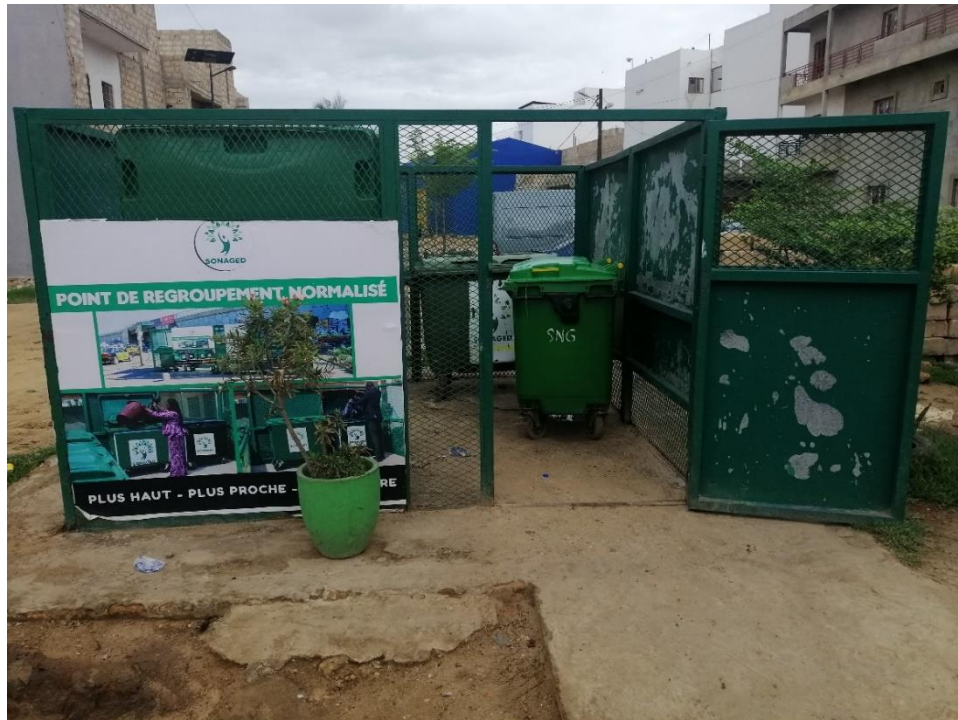
Photo 1 : Exemple de PRN à utiliser pour le stockage des lampes à incandescence, EDE-SEGU, juillet 2024
